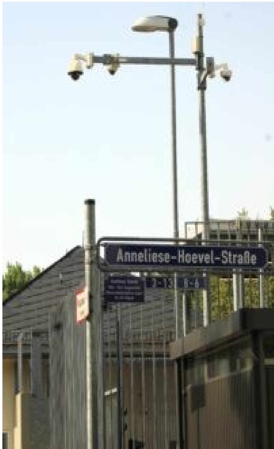
Kameramast an der Ecke Gießener Straße / Anneliese-Hoewel-Straße
